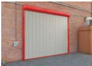
Установка противопожарной шторы в складском помещении
