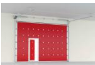
Установка противопожарных секционных ворот в складском помещении
